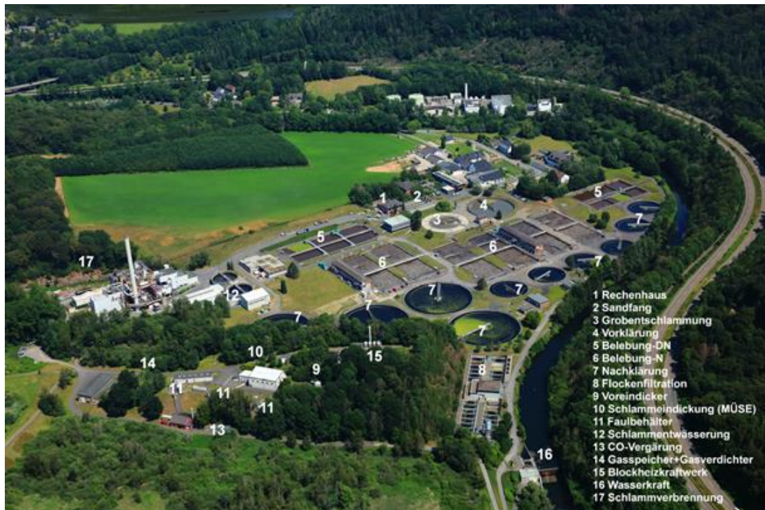
Abbildung 1.1: Kläranlage Buchenhofen (Foto: Wupperverband)
